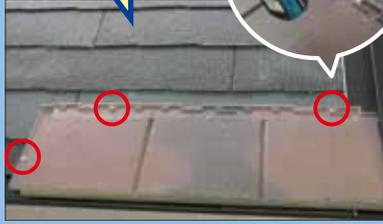
瓦の固定は、スクリーブビス3点留めだけ。電動工具による簡単な作業なので、施工の手間暇と作業時間を大幅に削減可能。また、古い平型化粧瓦を撤去せずリフォームできるので処分コストもかからない(※ルーフィング等のオプションに関しましては、別途ご相談ください)
