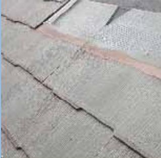
平型化粧瓦の隙間にほこりやゴミがつまり、毛細管現象で雨水を吸い上げた痕跡(釘穴より上に浸入)
