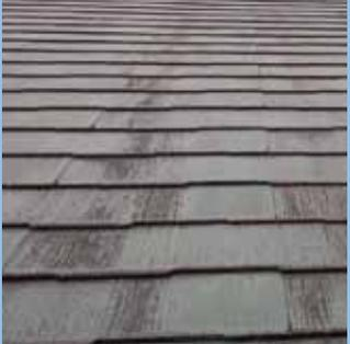
再塗装時の縁切り不足のため、毛細管現象で雨水を吸い上げて腐食
